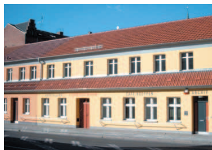
Das Koeppenhaus wurde nach der Sanierung im November 2002 eröffnet.
