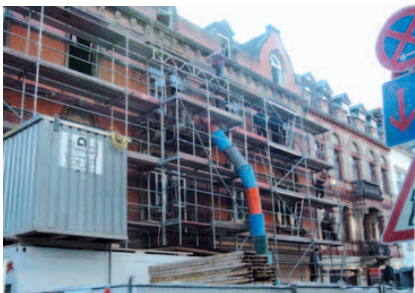
Die Bewohner aus dem Westend wollen nicht mehr wegziehen – die Geschäftsleute investieren. Fassadensanierung – Indikator für positiven Wandel
